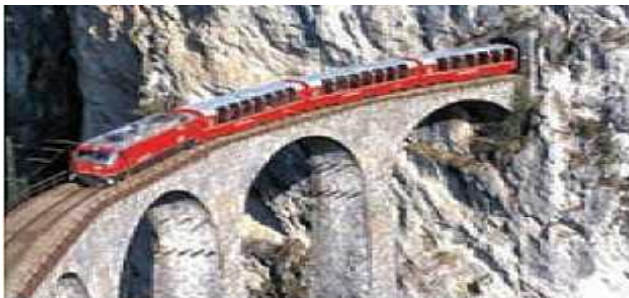
احداث تونل و پل برای عبور قطار در تاحیدای کوهستانی و برفگیر - سوئیس
