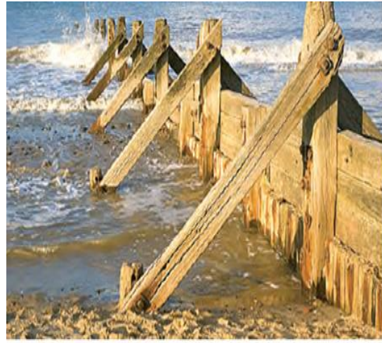
نصب حفاظ عمودی
